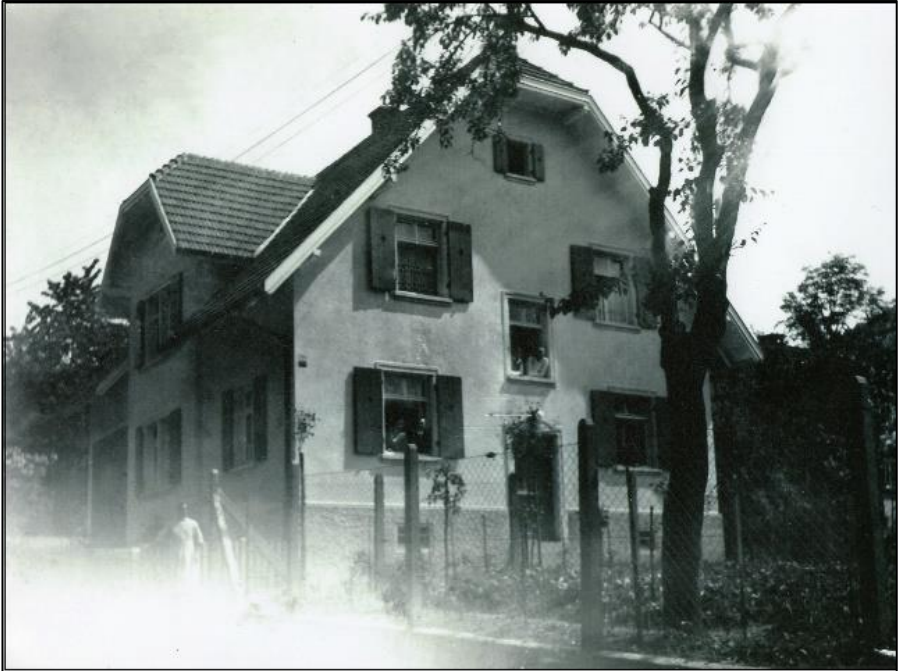
Haus Bühlweg 10 vor der Zerstörung
